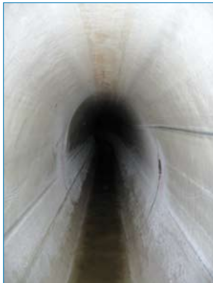
Blick in den sanierten Kanal
