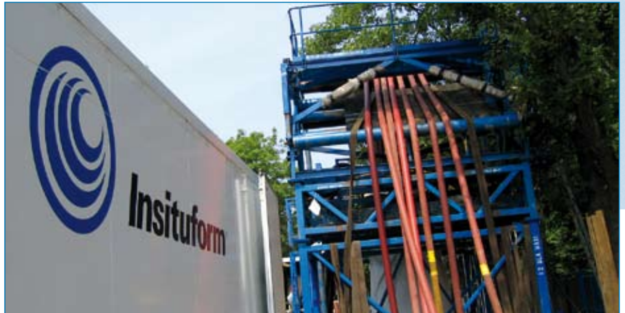
Die Baustelle während der Aushärtephase
