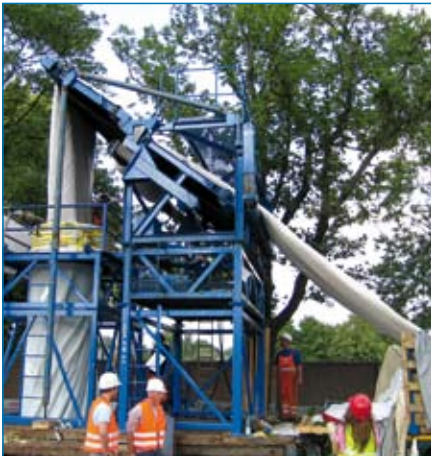
Einbau des Schlauchliners
