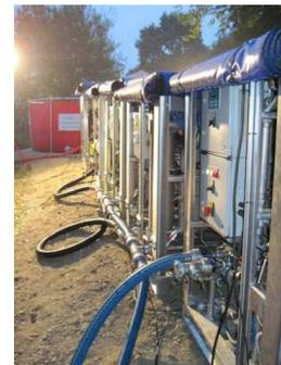
Das modular aufgebaute System verfügt über eine mehrfache Keimbarriere, u.a. Ultrafiltration über Keramikmembrane.
